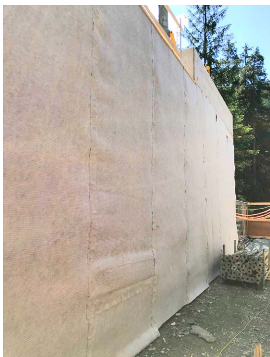
Drenaggio costruzioni sotto il livello del terreno
