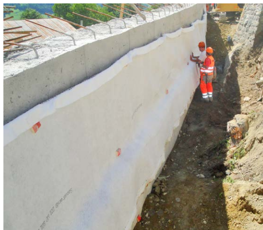
Drenaggio muro di sostegno
