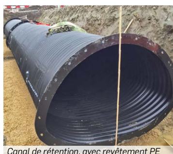
Canal de rétention, avec revêtement PE
