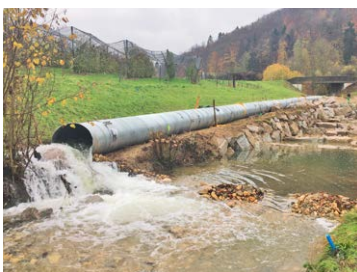
Conduite pour rivière enterrée
