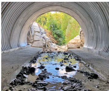
Bachdurchlass mit Banketten
