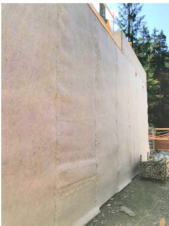
Entwässerung Bauten unter Terrain
