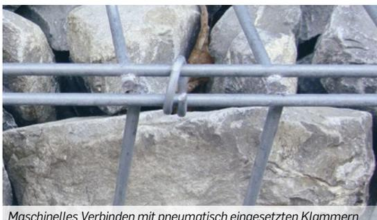
Maschinelles Verbinden mit pneumatisch eingesetzten Klammern
