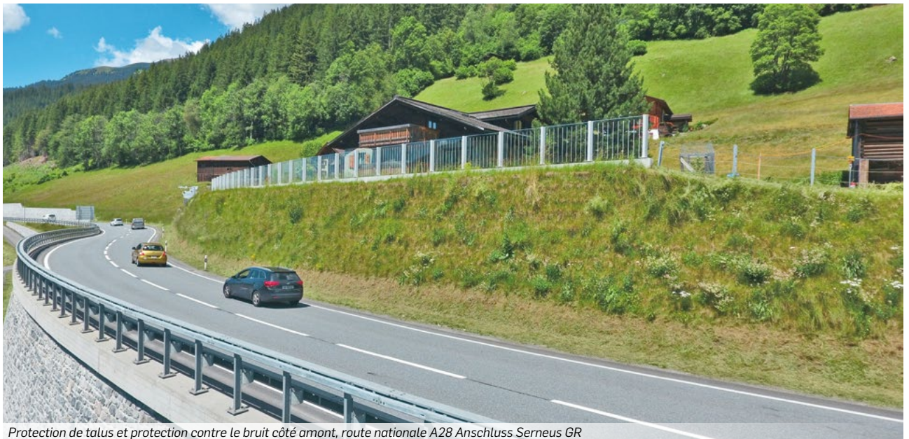
Protection de talus et protection contre le bruit côté amont, route nationale A28 Anschluss Serneus GR
