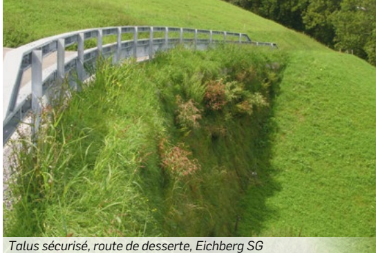
Talus sécurisé, route de desserte, Eichberg SG
