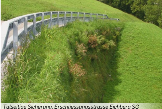
Talseitige Sicherung, Erschliessungsstrasse Eichberg SG
