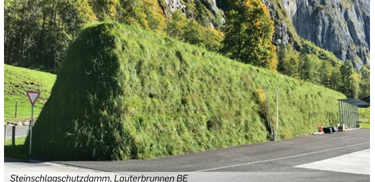
Steinschlagschutzdamm, Lauterbrunnen BE
