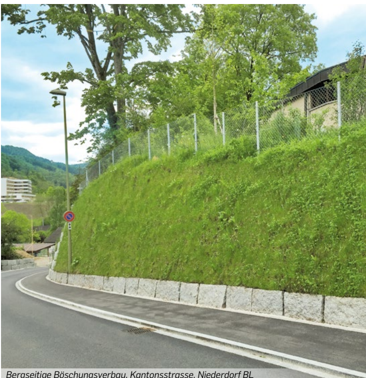
Bergseitige Böschungsverbau, Kantonsstrasse, Niederdorf BL
