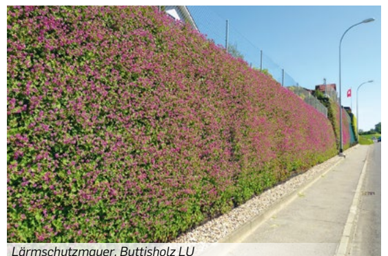
Lärmschutzmauer, Buttisholz LU
