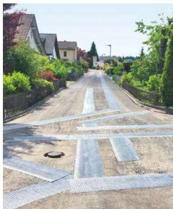
Assainissement route de quartier Buchs AG
