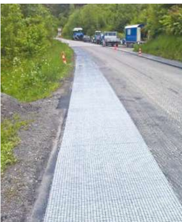
Assainissement des bords de chaussée (jonction ancienne / nouvelle couche de base)
