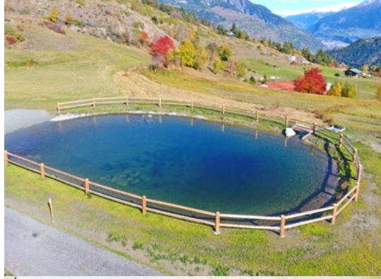
Étanchement d'un étang-réservoir pour extinction des incendies
