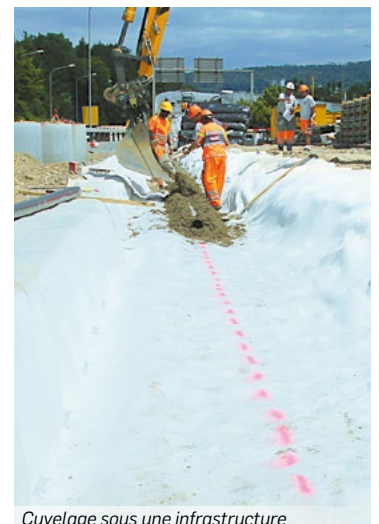
Cuvelage sous une infrastructure
