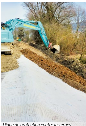
Digue de protection contre les crues
