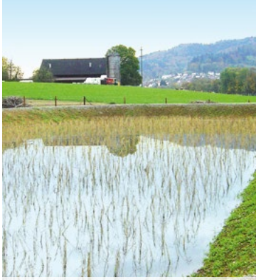
Bassin de rétention et de filtration
