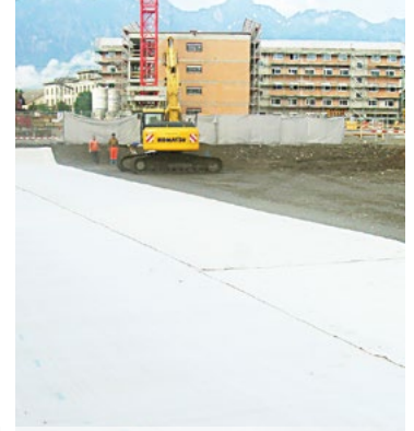
Assainissement d'une ancienne décharge
