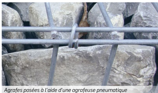
Agrafes posées à l'aide d'une agrafeuse pneumatique
