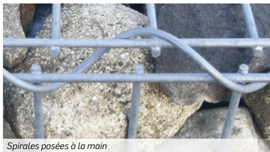
Spirales posées à la main
