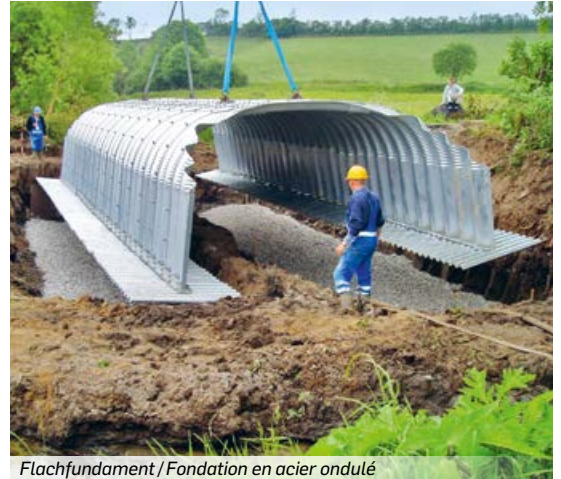
Flachfundament / Fondation en acier ondulé
