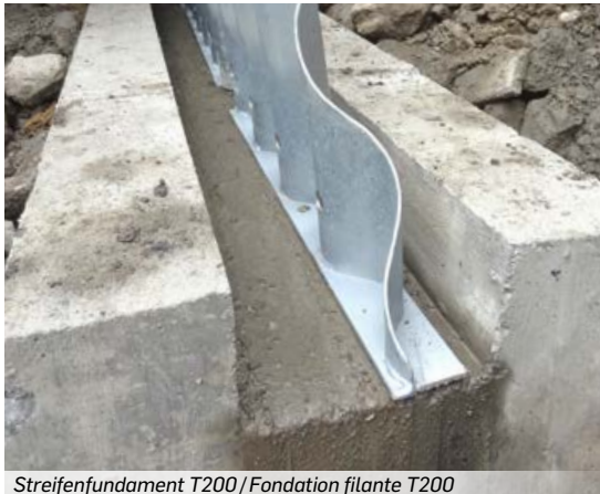
Streifenfundament T200 / Fondation filante T200
