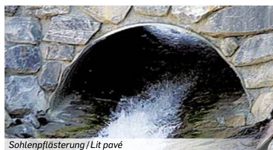
Sohlenpflasterung / Lit pavé
