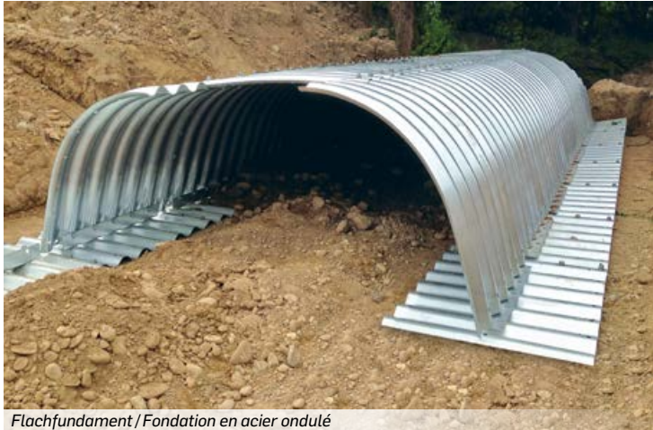
Flachfundament / Fondation en acier ondulé
