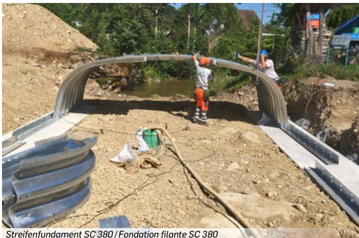
Streifenfundament SC 380 / Fondation filante SC 380
