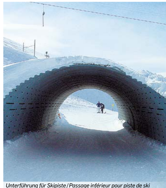
Unterführung für Skipiste / Passage inférieure pour piste de ski
