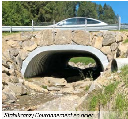
Stahlkranz / Couronnement en acier
