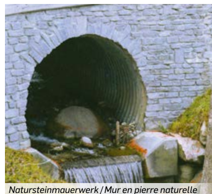
Natursteinmauerwerk / Mur en pierre naturelle
