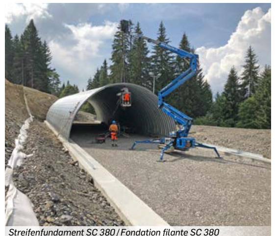
Streifenfundament SC 380 / Fondation filante SC 380
