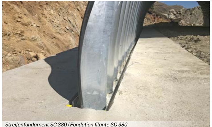
Streifenfundament SC 380 / Fondation filante SC 380
