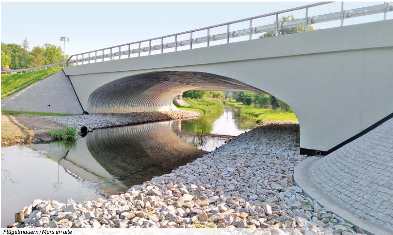
Flügelmauern / Murs en aile
