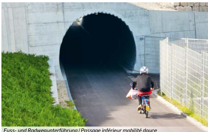
Fuss- und Radwegunterführung / Passage inférieur mobilité douce
