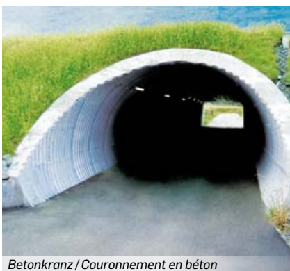
Betonkranz / Couronnement en béton
