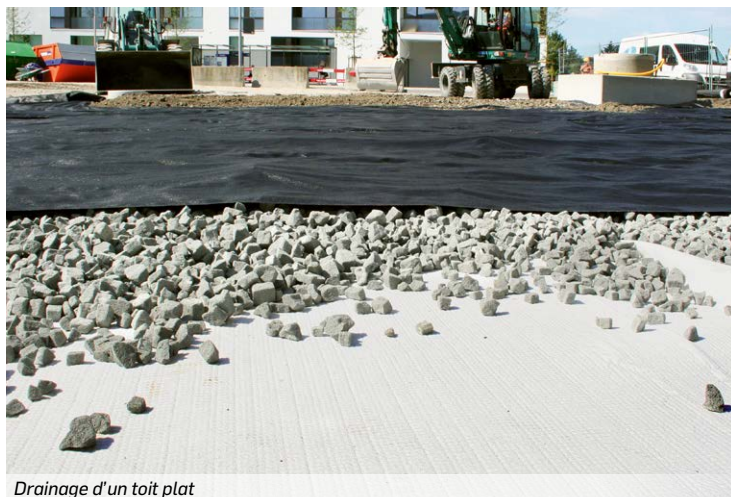
Drainage d'un toit plat
