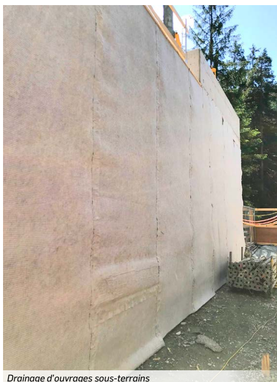
Drainage d'ouvrages sous-terrains
