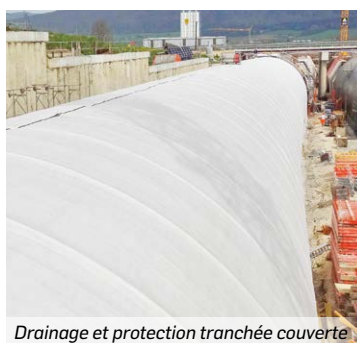
Drainage et protection tranchée couverte
