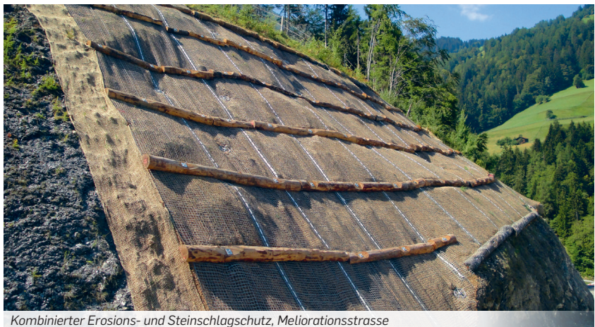
Kombinierter Erosions- und Steinschlagschutz, Meliorationsstrasse
