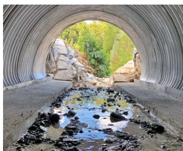
Sottopasso per riale con banchine
