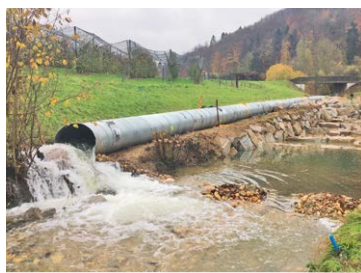
Conduttura d'acqua di un ruscello
